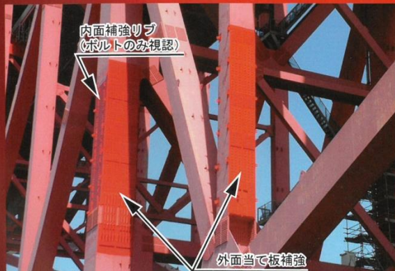
鋼板による部材補強
