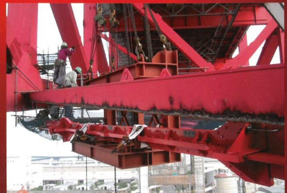
並列型制震ブレースの架設
