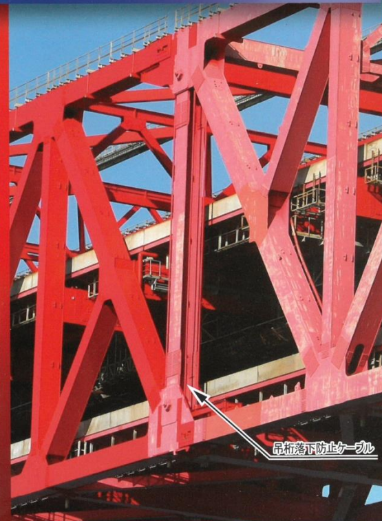
ゲルバー部の吊桁落下防止ケーブル
