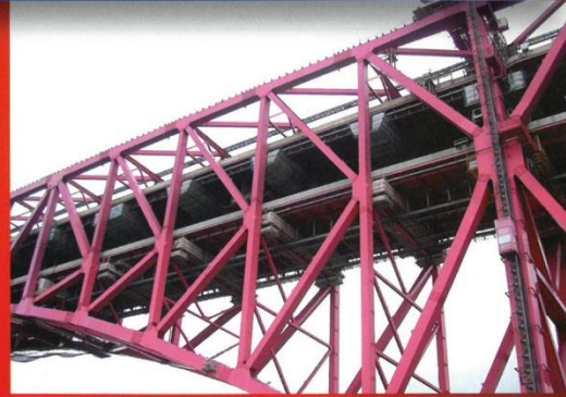
供用下での施工状況
