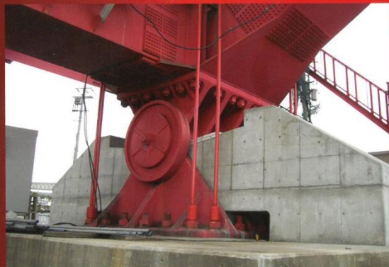
巨大な中間支承の浮き上がり防止PC鋼棒と変位制御型段差防止
