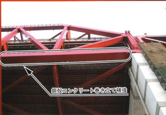
外観を損なわない鋼殻コンクリート巻き立て補強
